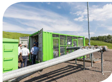
De pilots voor het innovatieve en wetenschappelijke onderzoek naar duurzaam stortbeheer zijn gestart
