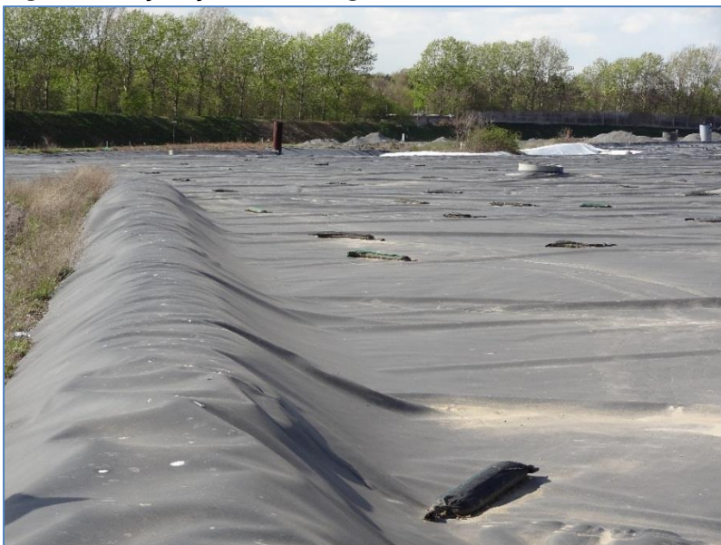
Figuur 10: Tijdelijke afdichting stortvak
